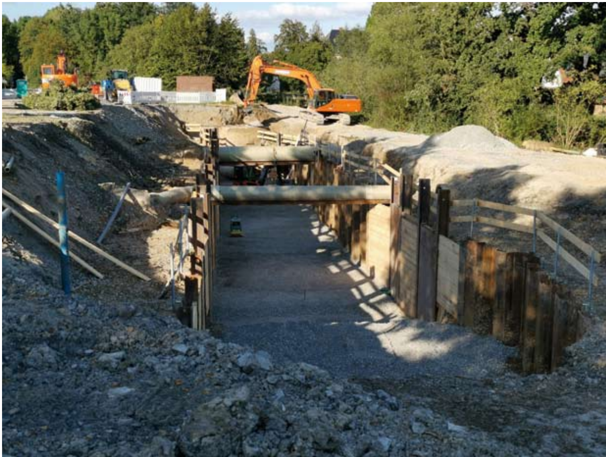
Blick in den Schacht für die 50 Meter lange, 10 Meter breite und 2 Meter tiefe Betonwanne des Überlaufbeckens.
