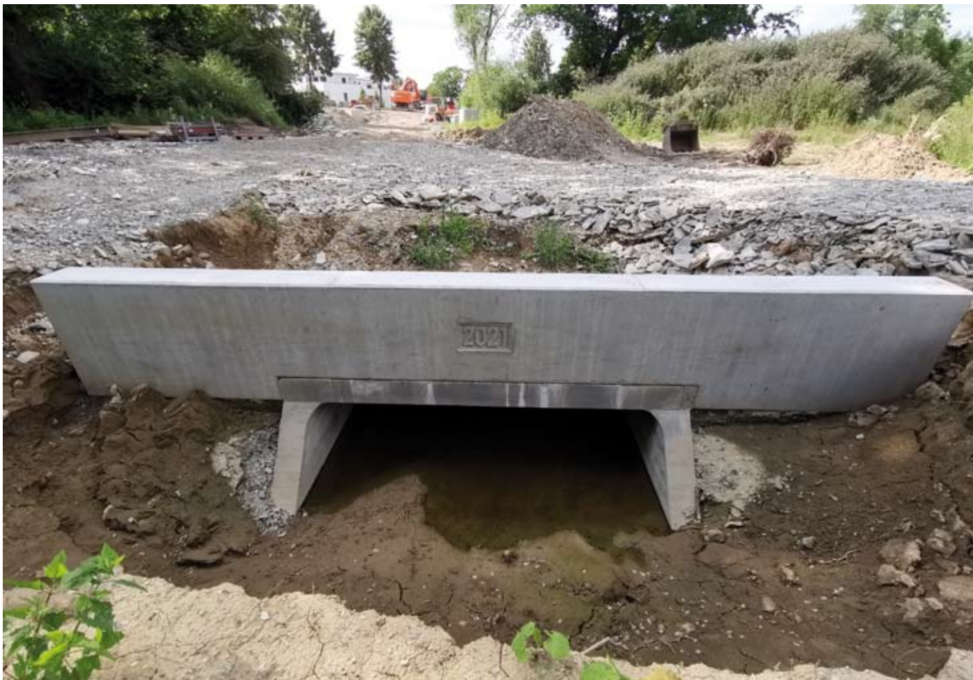
Das Auslaufbauwerk für das Überlaufbecken liegt jenseits der Alme, die von der Rohrleitung unterquert wird. Überschüssiges Wasser aus dem Becken wird über einen Graben in die Alte Alme eingeleitet, einen Verbindungslauf von der Alme zur parallel fließenden Lohme. Hinter dem Sägewerk fließen Alme und Lohme wieder zusammen.
