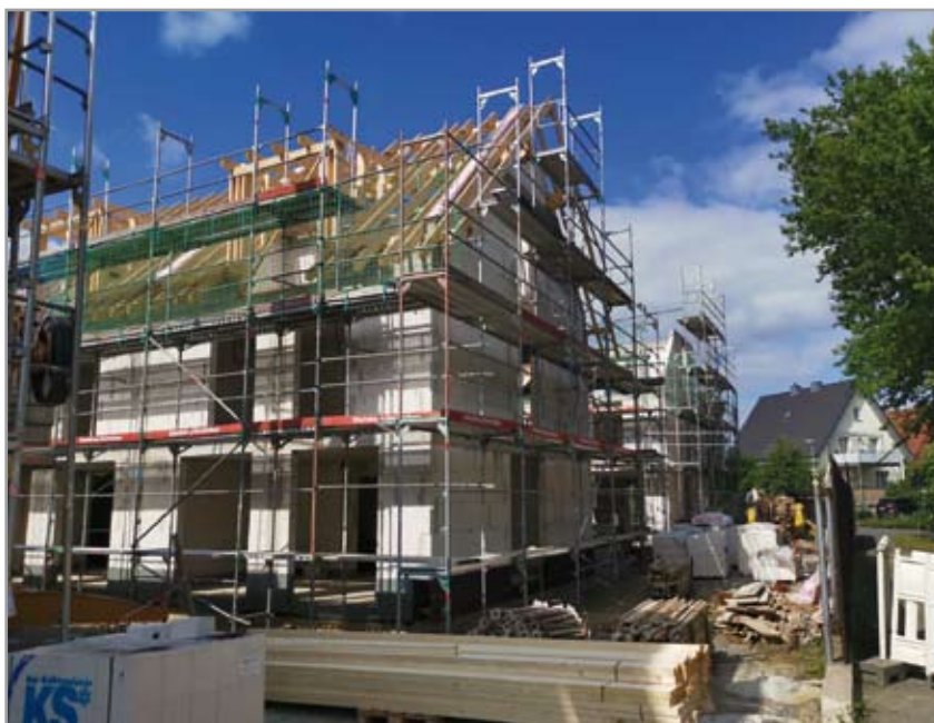
In Wewer wird fleißig gebaut. Auch am Niedernhof entstehen derzeit Mehrfamilienhäuser.
