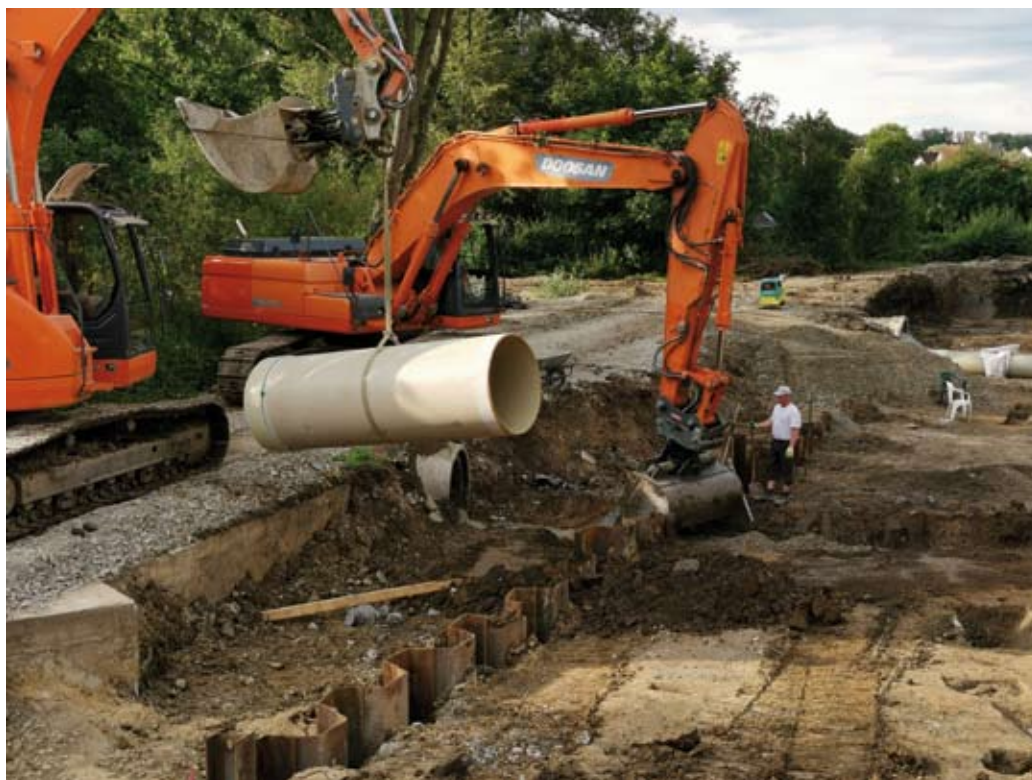
Hier wird der Überlauf des Rückhaltebeckens vorbereitet. Durch die mächtige Rohrleitung können im Falle eines anhaltenden Starkregens bis zu 3000 Liter Wasser pro Sekunde in die Alme abgeleitet werden. Fotos: Stienecke
