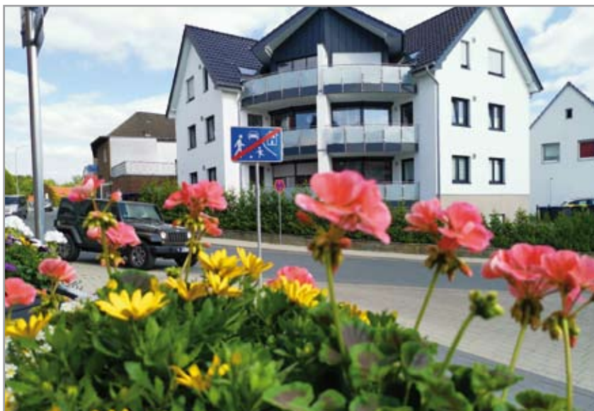
Dieses in jüngerer Zeit errichtete Mehrfamilienhaus steht prominent in der scharfen Kurve des Alten Hellwegs.
