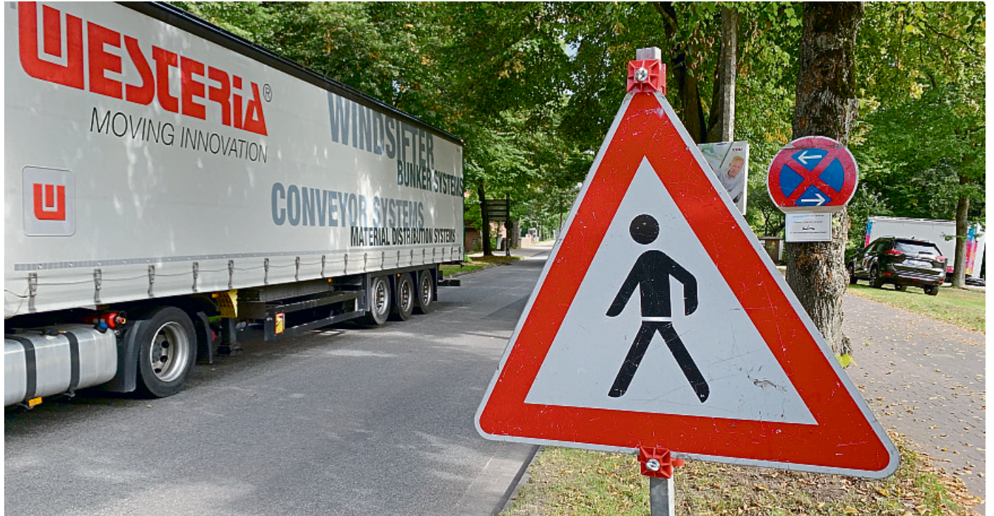
Gleich drei größere Baustellen wird es in den kommenden Wochen in und rund um Telgte geben. Unter anderem wird die Straße vom Baßfeld bis zur Günter-Grass-Brücke saniert. Ein Anhänger am Jägerhaus weist auf die Sperrung hin. Foto: Andreas Große Hüttmann
