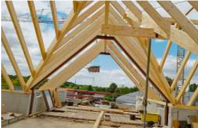
Experten rund um den Bau – das Team von Roßmüller & Steinhoff bietet umfangreichen Service. Foto: Rossmüller & Steinhoff
