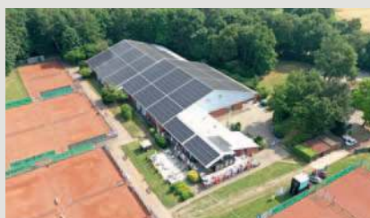
Das neue Hallendach mit 1470 Solarpannels
