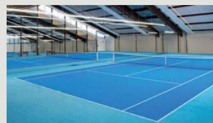
Neue LED-Beleuchtung mit Heizungssystem
