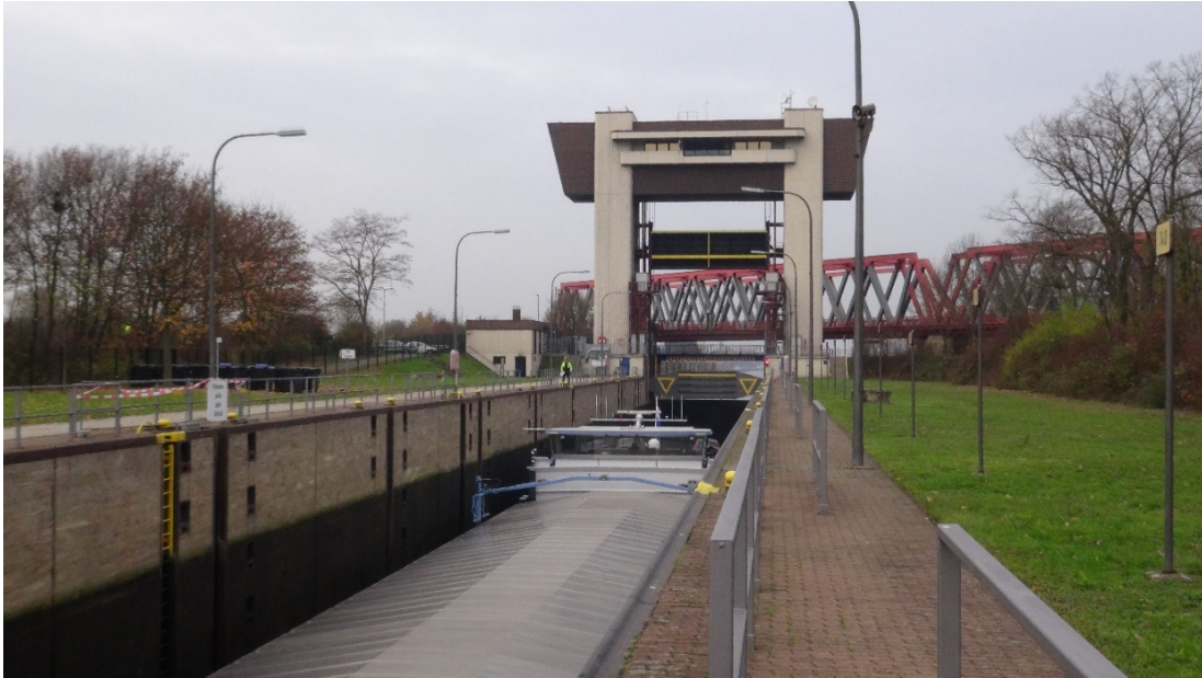
Abbildung 17: Schleuse Meiderich, Bergschleusung, Blick zu Tal (Foto: D. Busch, LANUV)
