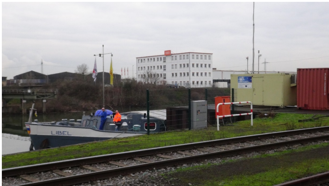
Abbildung 28: Messstation am Rheinkanal im Hafen Neuss (Foto: D. Busch, LANUV)
