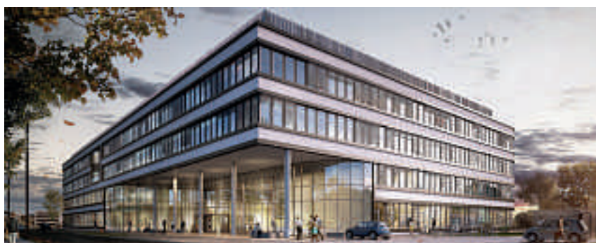
Das Gebäude zeichnet sich vor allem durch seine Energieeffizienz aus. Foto: Amprion
