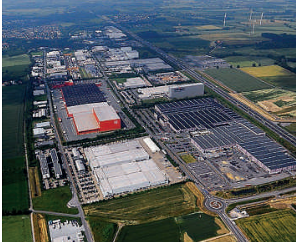
Das jüngste Gewerbegebiet Wahrbrink-West, in dem sich die Unternehmen Amazon, Euroroll und Thermo Sensor angesiedelt haben, wurde 2012 angrenzend an das Gewerbegebiet Wahrbrink erschlossen.
