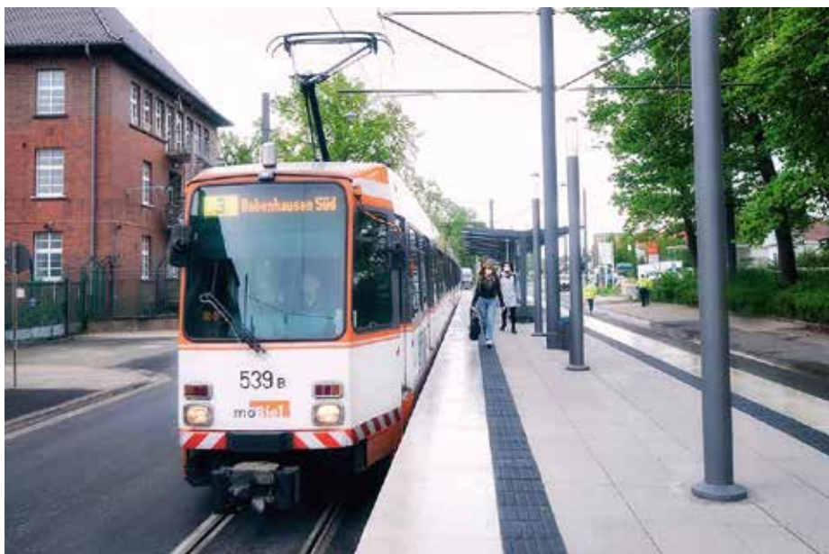
Barrierefrei Der Hochbahnsteig der Station Sieker Mitte wurde bedürfnisgerecht für alle Fahrgäste angepasst.
