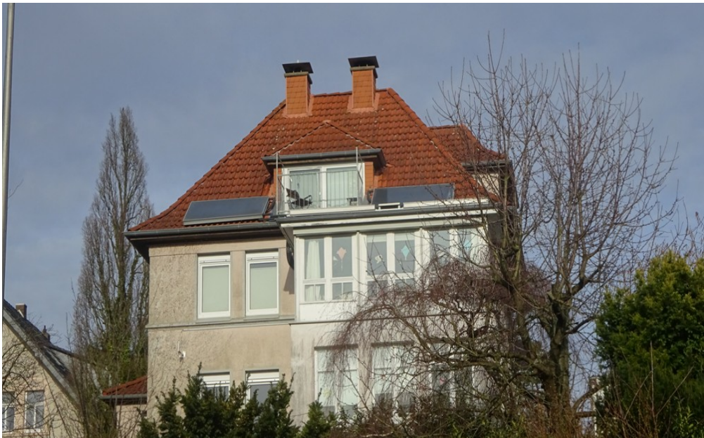
2020 Ansicht von der Paderborner Straße
