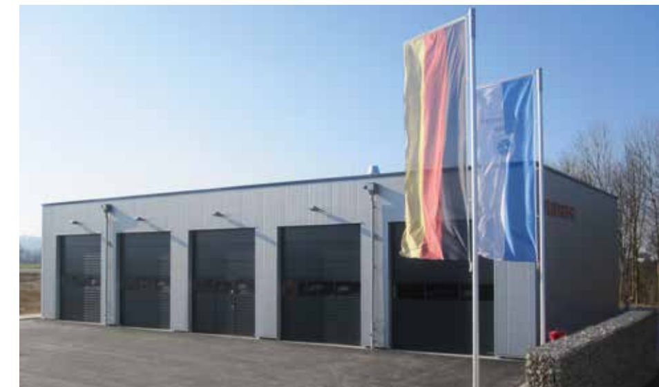
ab 2010: Gerätehaus Ost an der Voßheider Straße - Gemeinsame Nutzung der Löschgruppen Brake und Voßheide
