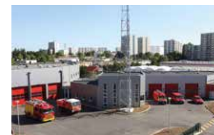
Feuerwache der Feuerwehr Vandœuvre
