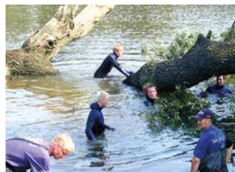
Sicherung der Elbdeiche beim Hochwasser im Jahr 2002
