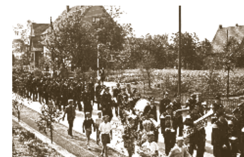
Festumzug (hier im Bereich der Uferstraße)
