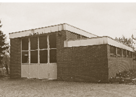
ab 1976 Feuerwehrgerätehaus an der Hauptstraße
