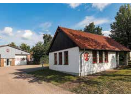
2004 Erweiterung und Umbau des Feuerwehrgerätehauses
