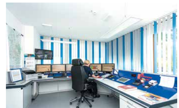
Nachrichtenzentrale Feuerwehr Stadt Lemgo, 2019
