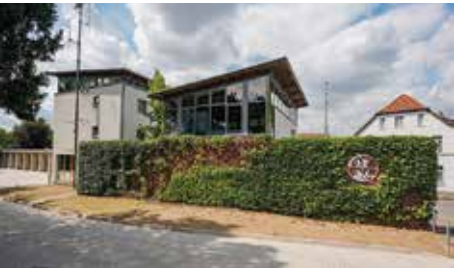
Einfahrt der Feuerwache am Regenstor, 2019
