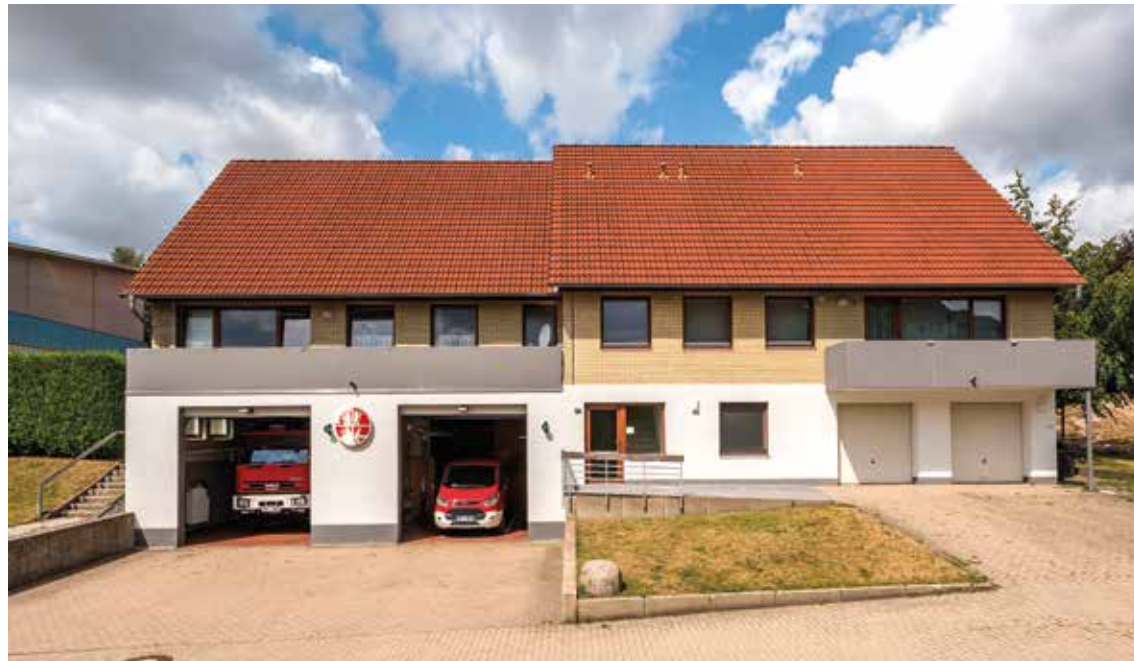
Umbau des Gerätehauses in Eigeninitiative, 2002
