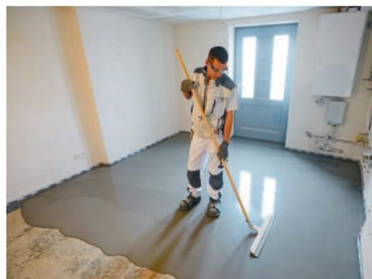
Ein ebener und wasserdichter Boden in einem Arbeitsschritt: Mit speziellen Materialien können Fachhandwerker Keller sanieren. Hausbesitzer profitieren von einem schnellen Ergebnis, wenig Aufwand und geringeren Kosten.
