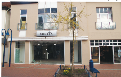
Die Renovierungsarbeiten am ehemaligen Ladenlokal der Textil-Kette Bonita (links vom Eingang des Café Fellmer) sind fast abgeschlossen. Dennoch kehrt Bonita nicht an den Standort zurück. Die Stadt Lage ist auf der Suche nach einem neuen Mieter.
