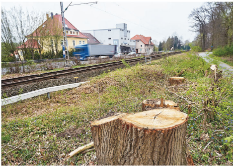
Im vergangenen Herbst hat die Bahn damit begonnen, solche Bäume fällen zu lassen, die eine Gefahr für die 15.000-Volt-Überleitung bedeuten. Nach Ostern werden die Arbeiten fortgesetzt auf dem Abschnitt von Düwels Mühle (im Hintergrund in der Bildmitte) bis zur Fußgängerampel an der Altdorfer Straße.
