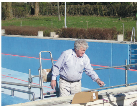
Hermann Eikmeier bei der Instandsetzung des Beckenkopfes im Freibad Heiden.
