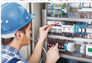
Eine großzügig geplante Elektro- und Telekommunikationsvernetzung macht Häuser zukunftssicher. Foto: djd/Deutsches Kupferinstitut/shutterstock
