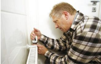
Beim hydraulischen Abgleich überprüft ein Fachhandwerker die Einstellungen der Heizungsanlage und passt sie an den tatsächlichen Bedarf des Hauses an. Foto: djd/IWO - Institut für Wärme und Oeltechnik
