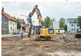
Momente werden sogenannte „Spundwände“ gesetzt, um die Baugrube zu sichern und das Grundwasser absenken zu können. Fotos: wj
