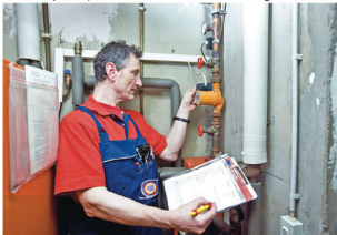
Der Fachhandwerker beurteilt die alte Heizungspumpe und gibt dann konkrete Tipps, wie man vom staatlichen Programm zur Heizungspumpentürmung profitieren kann. Foto: djd/ZVSHK
