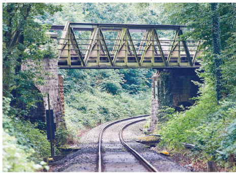
Von April 2019 bis Oktober 2019 soll in der Nähe des Bahnhofs Schötmarsche Straße die Eisenbahnbrücke der Strecke Herford-Lage-Detmold erneuert werden. Während dieser Zeit soll es keinen Zugverkehr auf den Schienen (im Vordergrund) zwischen Lage und Oerlinghausen geben. Foto: wi
