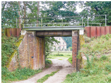
Die Eisenbahnbrücke der Strecke Lage - Lemgo, die in Heßloh über den Wappen-Wanderweg führt, soll im Jahr 2019 erneuert werden, teilten die Lagenser Grünen im Dezember 2014 mit. Foto: wi
