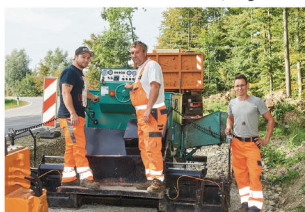
Die Mitarbeiter des städtischen Lagenser Bauhofs - André Franke, Bernd Dauskardt und Simon Eichhorn (von links) - bereiten den Untergrund vor, der für den Bürgeradweg anschließend asphaltiert wird. Ganz links die ausgebaute Kurve der Helfper Straße. Foto: wtl
