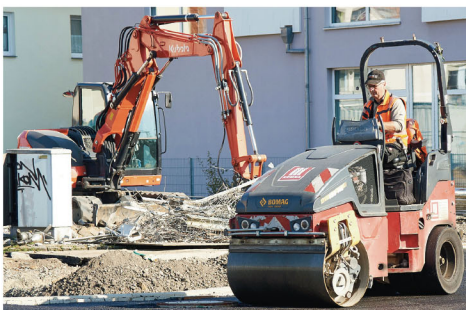
Ende vergangener Woche wurden die Parkplätze und Zufahrten des „Lagenser Forums am Drawenhof“ asphaltiert. Foto: wi
