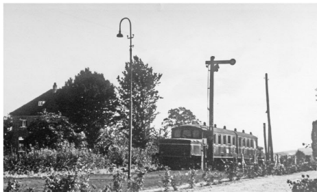
Elektromobilität früher: Ein ETA 175 auf dem Weg vom Bahnhof Oerlinghausen nach Lage.
