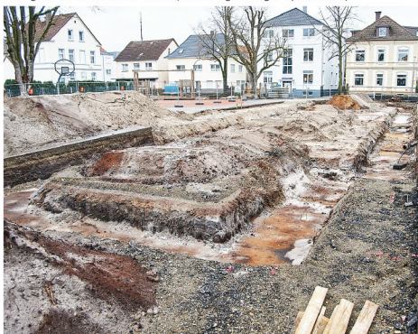
Der Neubau entsteht dort, wo früher die beiden, mittlerweile abgerissenen Toilettengebäude standen. Die Tiefbaurarbeiten haben im Dezember begonnen. Die Grundfläche des Neubaus ist deutlich zu erkennen. Foto: wj
