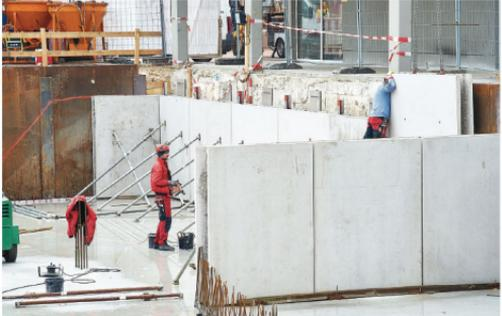
In den Tagen vor Ostern wurden die Innenwände der Tiefgarage angeliefert, aufgestellt und montiert.
