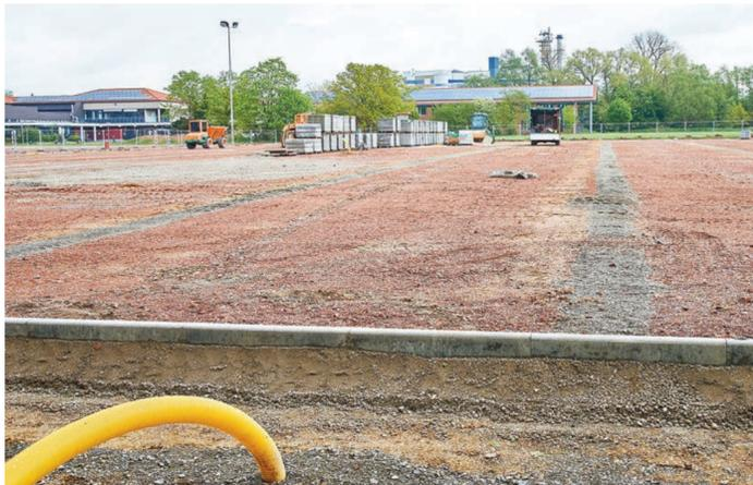
„Bergfest“ auf dem Werreanger: Hier begannen Anfang April die Bauarbeiten für Lages ersten Kunstrasenplatz mit dem Rückbau des Tennisplatzes (Belag, Pflasterwege). Ende Mai soll der neue Platz fertig sein. Im Vordergrund ein Teil der neuen Rohrdrainage und neu einbetonierte Kantsteine.
