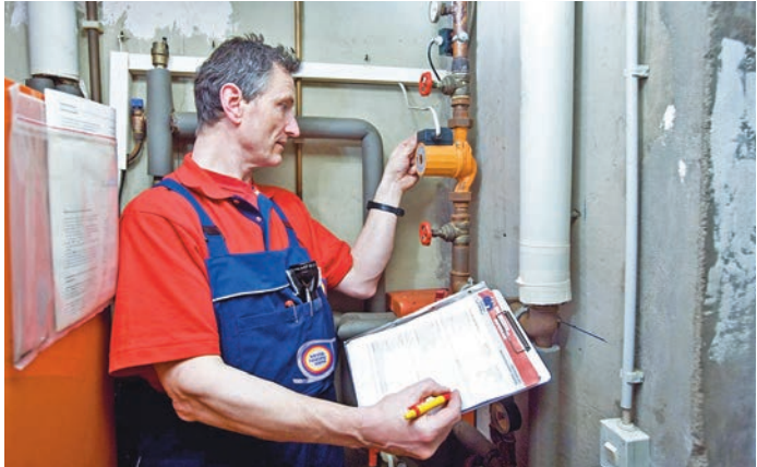
Der Heizungs-Check kann beispielsweise den hohen Stromverbrauch alter Pumpen aufdecken. Dabei wird zudem auch zu viel Wärme vom Kessel in die Wohnräume transportiert. Foto: djd/ZVSHK
