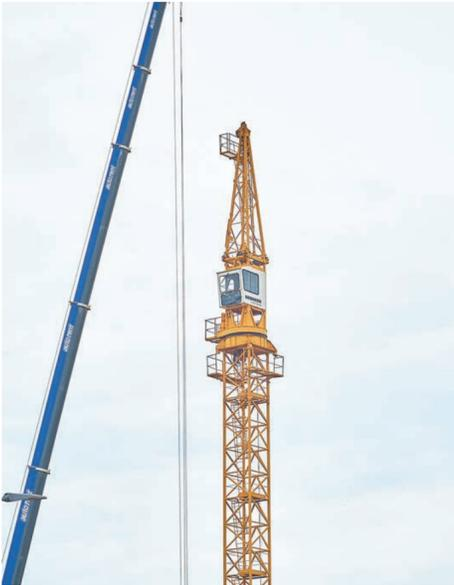
Gipfeltreffen: Mit Hilfe eines Autokrans (links) wurde der Baustellenkran errichtet.
