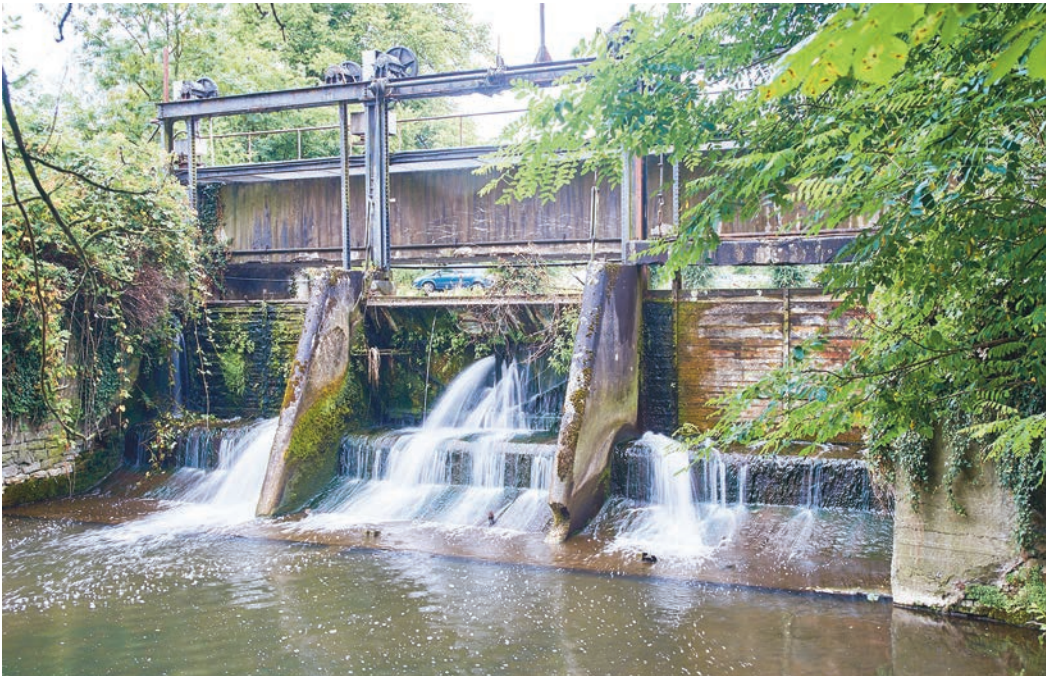
Das Stauwehr an der Stauffenbergstraße beeinflusst nach Erkenntnissen der Realschüler die Ökologie der Werre oberhalb des Wehres, und zwar nicht zum Positiven. Eine Verlangsamung der Fließgeschwindigkeit begünstigt eine Verschlämme des Gewässerbodens.
