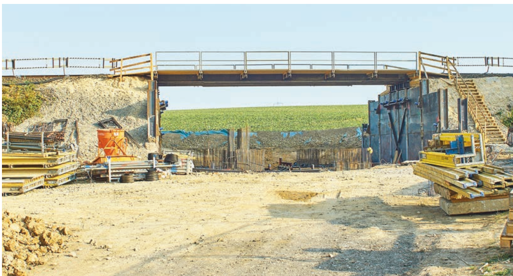
Die frühere Steinbrücke über den Wappen-Wanderweg in Heßloh ist abgerissen worden und ein breiter Durchbruch ist entstanden. Zur Zeit rollt der Zugverkehr über eine Behelfskonstruktion.
