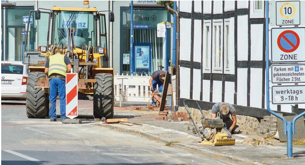
Der Energienetzbetreiber Westfalen Weser Netz erneuert die Stromversorgungsleitungen im Bereich Lange Straße und Friedrichstraße.
