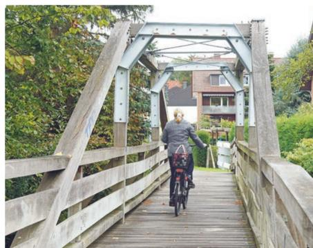
ken und mit diagonalen Spannstäben zu versteifen. Diese Arbeiten wurden übernommen und ausgeführt von einem ortsansässigen Industriebauunternehmen, das die Stahlkonstruktion im eigenen Hause anfertigte und diese in der vergangenen Woche in die Holzkonstruktion einbaute. Und zwar einen ganzen Monat eher als ursprünglich geplant.
