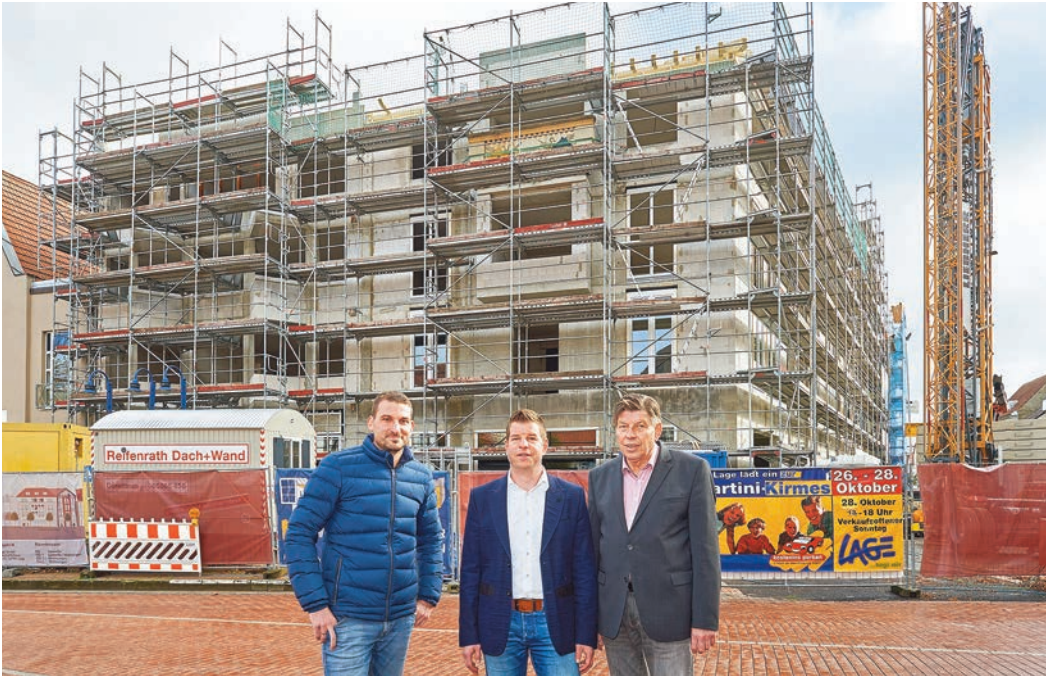
Laden ein zur Besichtigung der neuen Wohnungen (von links): Martin Kampeter sowie Gunnar und Klaus Mölling.
