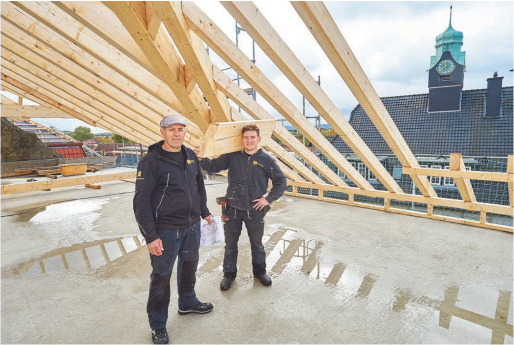
Zimmermeister Peter Block (links) und Auszubildender Hesekeil Revoller (beide von Block-Holzbau, Lage) montierten in den jüngsten Tagen den Dachstuhl. Von hier kann man bis zum Hermannsdenkmal schauen. Fotos: wi
