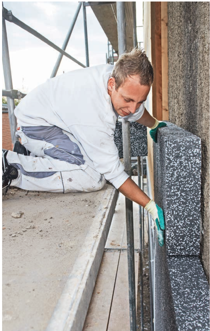
Für die Dämmung der Fassade lassen sich staatliche Fördermittel nutzen. Foto: djd/Qualitätsgedämmt e.V./Ingo Bartussek - Fotolia
