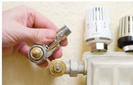
**Kann mehr als zehn Prozent vom Jahreswärmeverbrauch ausmachen: Durch einen hydraulischen Abgleich lassen sich notwendigen Heizungswasser-Durchflüsse mit modernen Heizkörperventilen und einer neuen Pumpe exakt einstellen.**
