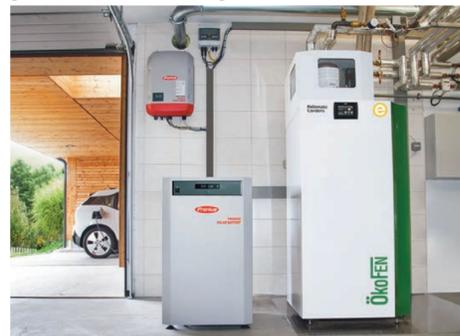
Durch die Kombination von stromerzeugender Pellettheizung, Stirlingmotor, Photovoltaikanlage und Stromspeicher wird der für den Haushalt benötigte Strom ausschließlich aus Holzpellets und der Kraft der Sonne erzeugt. Foto: djd/ÖkoFEN
