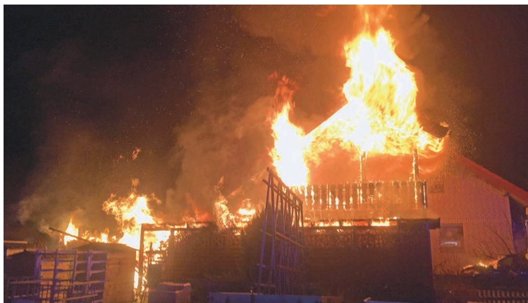
Die Flammen greifen von der Dachterrasse auf dem Carports über auf das Obergeschoss und den Dachstuhl des Wohnhauses. Foto: Feuerwehr Lage
