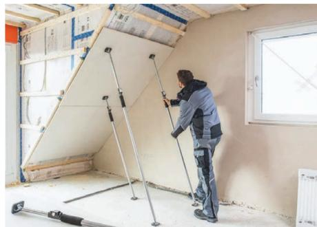
Bei Trockenbauarbeiten im Haus sind einfach zu bedienende Montagestützen eine wichtige Arbeitshilfe. Foto: djd/Bessey Tool
