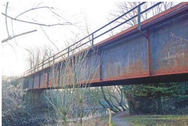
Über die Werre führt in der Nähe der Pottenhauser Straße diese Brücke. Die Stahlträgerkonstruktion wird ersetzt durch einen Stahlverbundüberbau.
