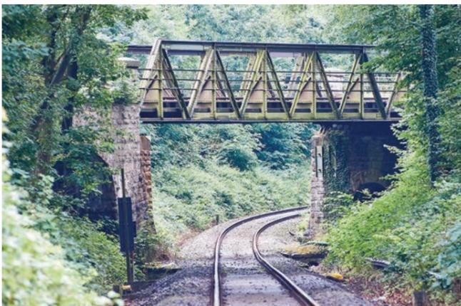
Die Brücke des Kreuzungsbauwerks besteht aus zwei Natursteingewölben (links und rechts) und einem Stahlüberbau in der Mitte. Alle drei Brückenelemente werden ersetzt durch eine Stahltrögbrücke.
