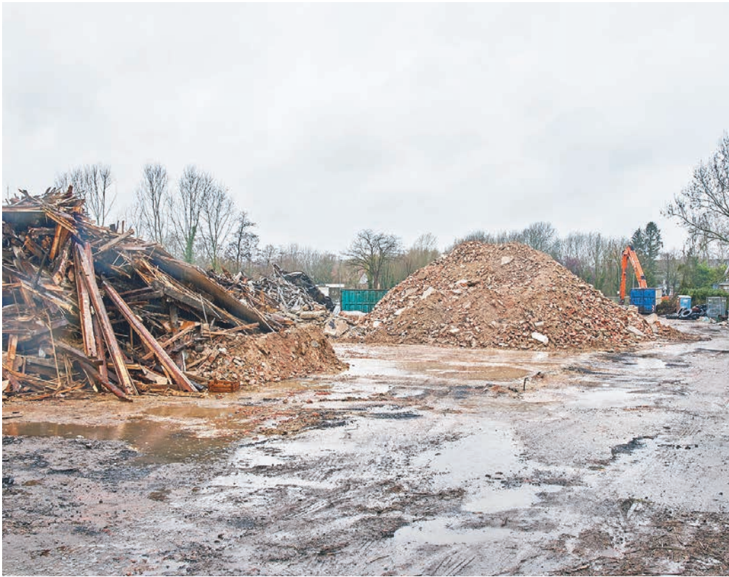
Auf dem Abrissgelände zwischen Färberstraße (etwas weiter rechts) und Friedrich-Petri-Straße (im Hintergrund) sollen ein Lidl-Markt und ein DM-Drogeriemarkt angesiedelt werden. Wenn die Politik nicht festlegt, hier auch Wohnraum zu schaffen, versäume sie eine „nachhaltige Entwicklung der Innenstadt“, kritisiert die FWG.
