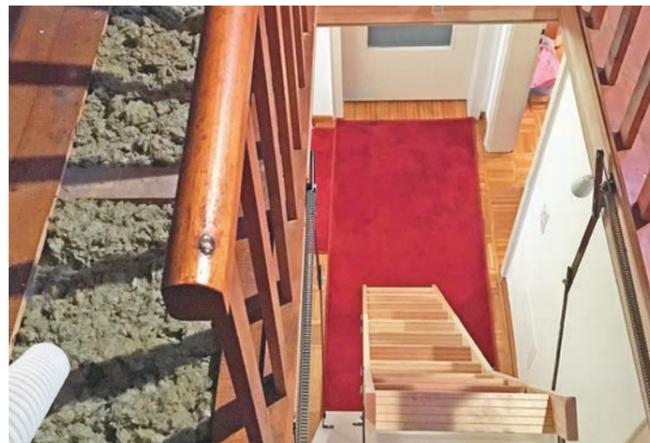
Dieser flauschige Dämmstoff besteht aus groben, biolöslichen Steinwolleflocken und eignet sich insbesondere für offenes Aufblasen. Der Strom für die Herstellung der Flocken kommt komplett aus erneuerbaren Energien. Foto: djd/www.ecofibre.de
