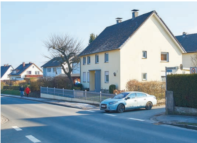
Die Einmündung des Grasweges auf die Breitenheider Straße wird verbreitert. Hecke und Mauer (rechts) werden abgetragen. Foto: wi
