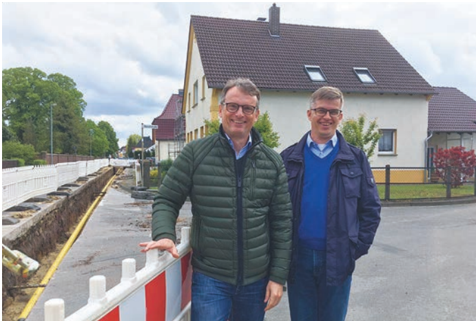
CDU-Bürgermeisterkandidat Stefan Everding und CDU-Stadtverbandsvorsitzender Michael Biermann an der Baustelle Pottenhauser Straße, Ecke Hasselstraße, in Lage.
