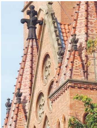
Ziegelgemauerte Turmhelme an der Dortmunder Liebfrauenkirche. Foto: Thomas Parent
