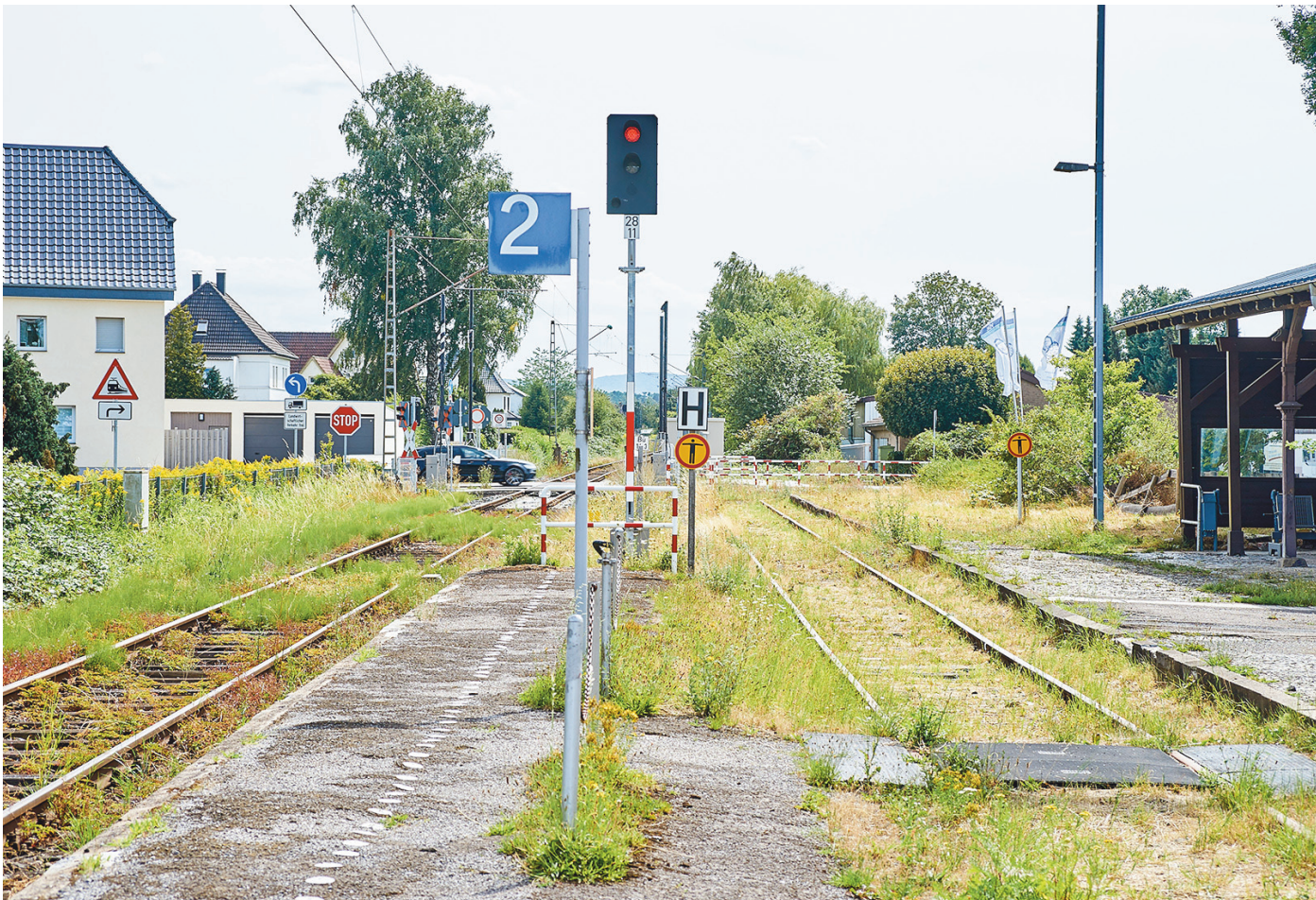
Das nicht mehr genutzte Bahngleis 1 (rechts) soll überbaut werden. Der Bahnsteig (Gleis 2, links) soll auf 150 Meter verlängert und auf 76 Zentimeter aufgehöhht werden. Ein barrierefreier Einstieg ist aufgrund der zu niedrigen Bahnsteigkante zur Zeit nicht möglich. Das Foto entstand zwei Tage vor Einrichtung der Baustelle.
