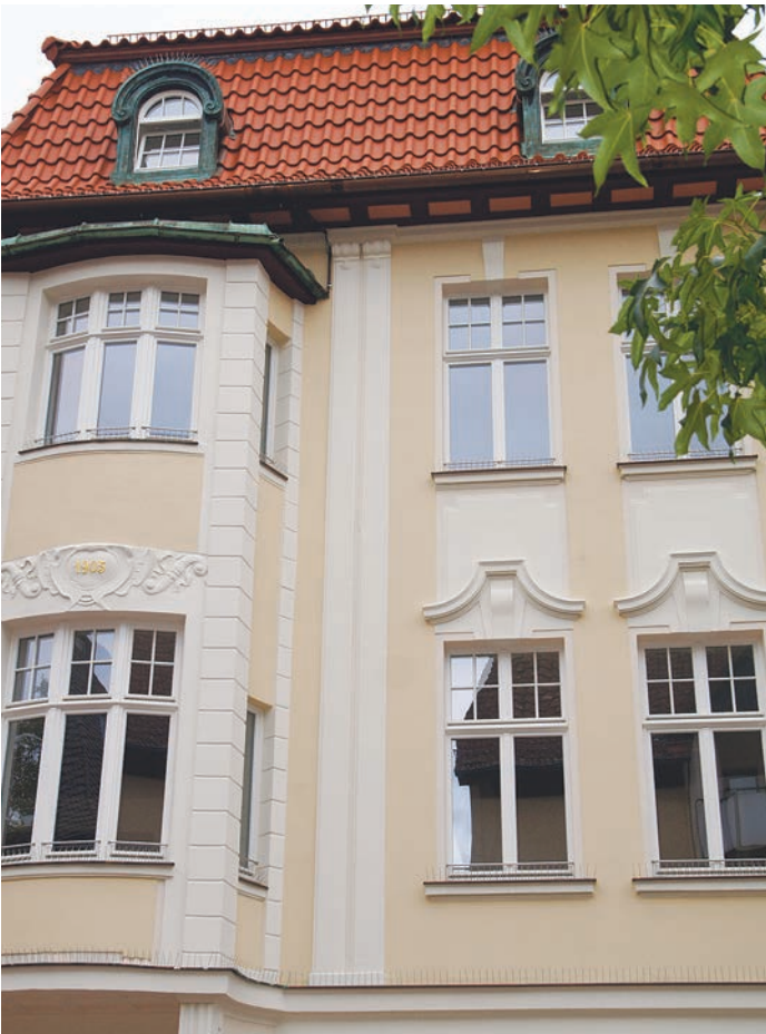
Stopp 1 der Fahrradtour ist am Haus Krügermeyer in der Langen Straße. Foto: th
