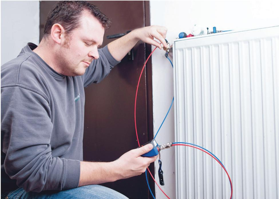
Bei lauten Geräuschen der Heizung oder einer ungleichmäßigen Wärmeverteilung ist der Fachmann gefragt: Mit einem hydraulischen Abgleich sorgt er für Abhilfe. Foto: djd/AFRISO
