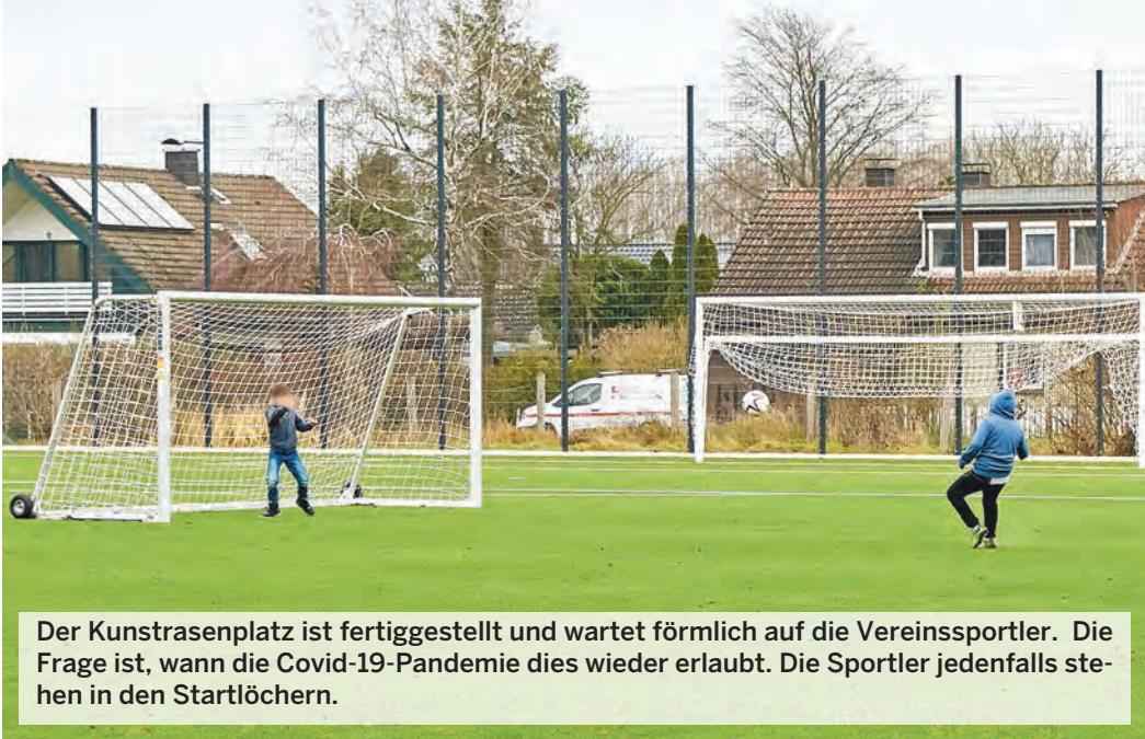
Auf dem „Nebenplatz“ der „Haferbach-Kampfbahn“ in Kachtenhausen ist in den vergangenen Monaten Lages dritter Kunstrasenplatz (106 x 68 Meter) entstanden; im Hintergrund die 1994 eingeweihte Tennis- und Mehrzweckhalle. Fotos: wi
