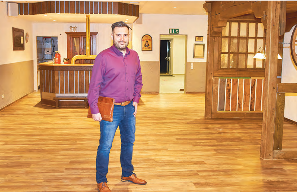
Aufbruch: TuS-Geschäftsführer Fabian Pohl inmitten einer (aufgeräumten) Baustelle: Der neue Fußboden in der 3. Halbzeit ist bereits verlegt. Es stehen aber noch einige Arbeiten an. Foto: wi
