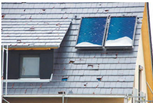
Eine sogenannte zweite wasserführende Ebene kann bei Beschädigungen der Dachziegel weitergehende Wasserschäden am Haus verhindern.
