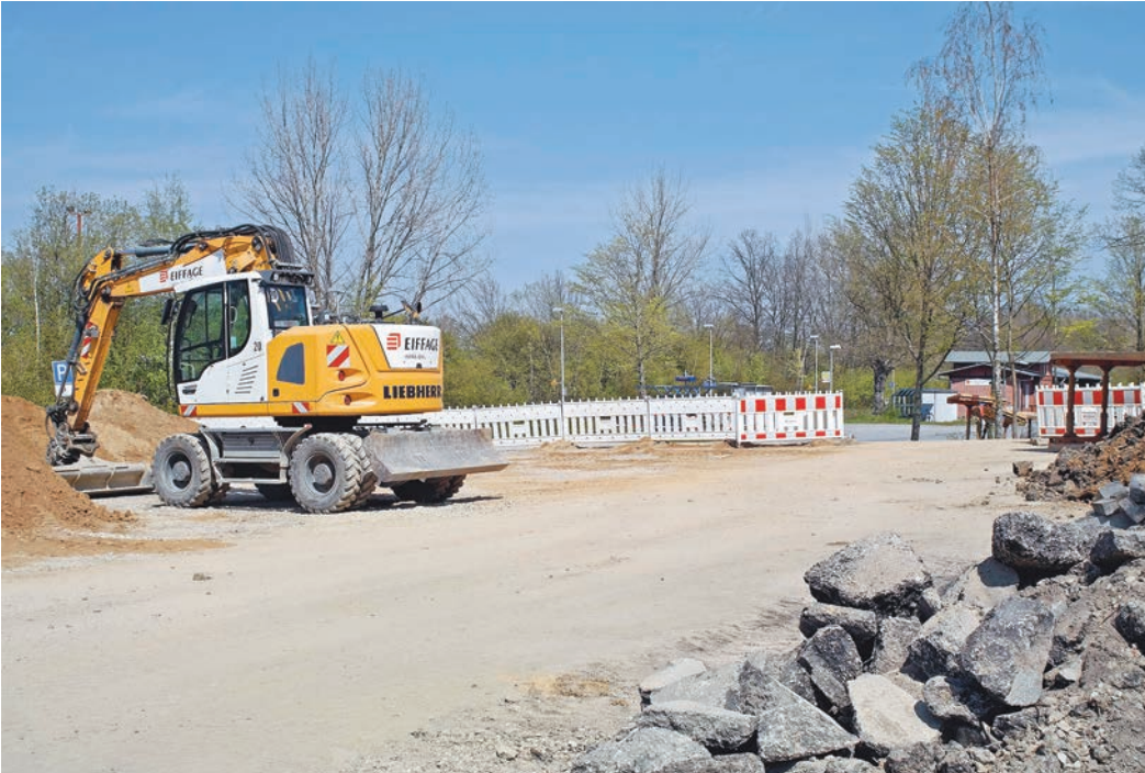
Der vor zwei Jahren provisorisch angelegte Pkw-Parkplatz ist wegen der benachbarten Kanalbauarbeiten zur Zeit als Stellplatz nicht nutzbar. Aber wenn der Platz in einigen Monaten gepflastert sein wird, können hier wieder bis zu 45 Autos geparkt werden.
