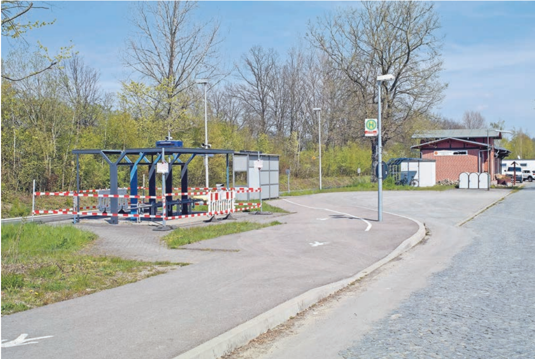
Die jetzige Haltestelle am Bahnhof und der Wendepunkt erfüllen zwar ihren Zweck - mehr aber auch nicht und sind erkennbar in die Jahre gekommen. Ab Juni wird hier eine neue Haltestelle gebaut, um die ÖPNV-Infrastruktur deutlich zu modernisieren. Fotos: wi
