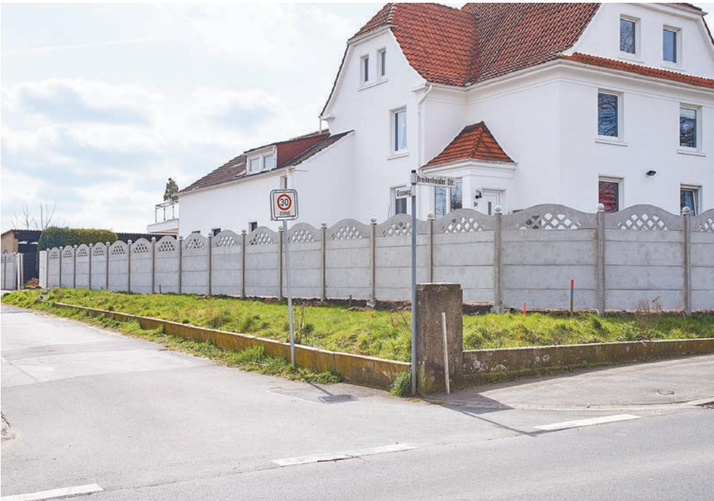
Die jüngst errichtete Grundstückseinfriedung im Straßeneinmündungsbereich Breitenheider Straße / Grenzweg wird nicht wieder entfernt. Sie entspreche den hier geltenden Bebauungsplanvorgaben und diene dem Sicht- sowie Schallschutz, so der Bau- und Planungsausschuss. Die Straßeneinmündung soll verbreitert werden; zuerst für den Baustellenverkehr, dann für den Anliegerverkehr des Neubaugebietes. Foto: wi
