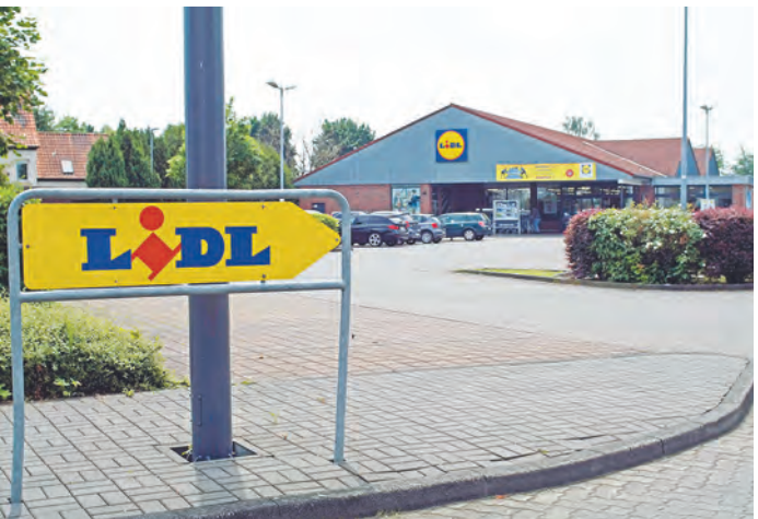
Eine knappe Mehrheit im Bau- und Planungsausschuss hat nichts dagegen, dass die Lidl-Verkaufsfläche an der Triftenstraße von 800 auf 1.500 Quadratmeter erweitert wird - ohne Sortimentsausweitung. Foto: wi
