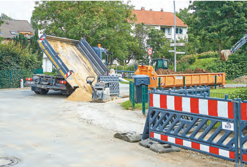
Vor Beginn der eigentlichen Straßen- und Kanalbauarbeiten lassen die Stadtwerke an neuen Wasserleitungen und an der Stromversorgung arbeiten. Fotos: wi
