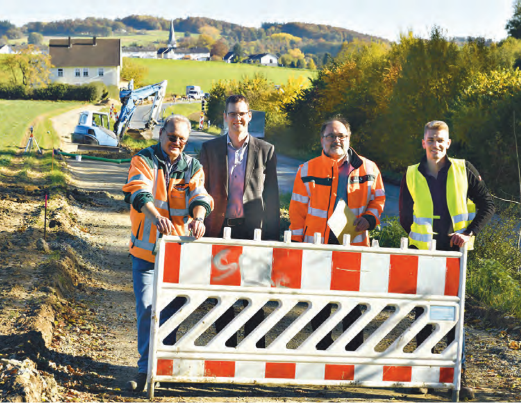
Von links: Martin Gronert (Straßen.NRW, Bauleiter vor Ort), Bürgermeister Matthias Kalkreuter, Jens Köhler (Straßen.NRW, Projektleiter), Jürgen Schartner (Richter Tiefbau). Foto: rp
