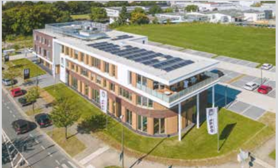
Die PV-Anlage versorgt die Luft-Wasser-Wärmepumpen mit Energie
